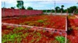
Estrutura para Quadra de areia
