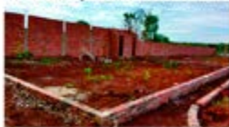
Estrutura para Duas Piscinas
