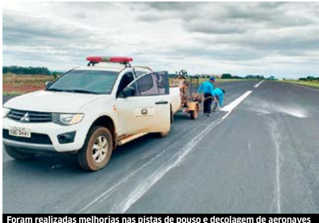
Foram realizadas melhorias nas pistas de pouso e decolagem de aeronaves
