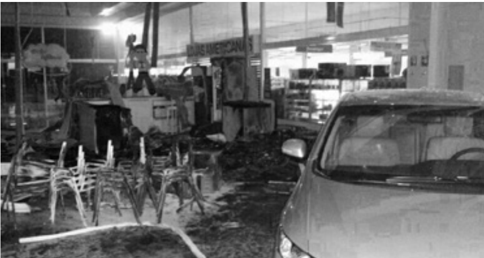
Incêndio destruiu todo o quiosque da empresa Did's
