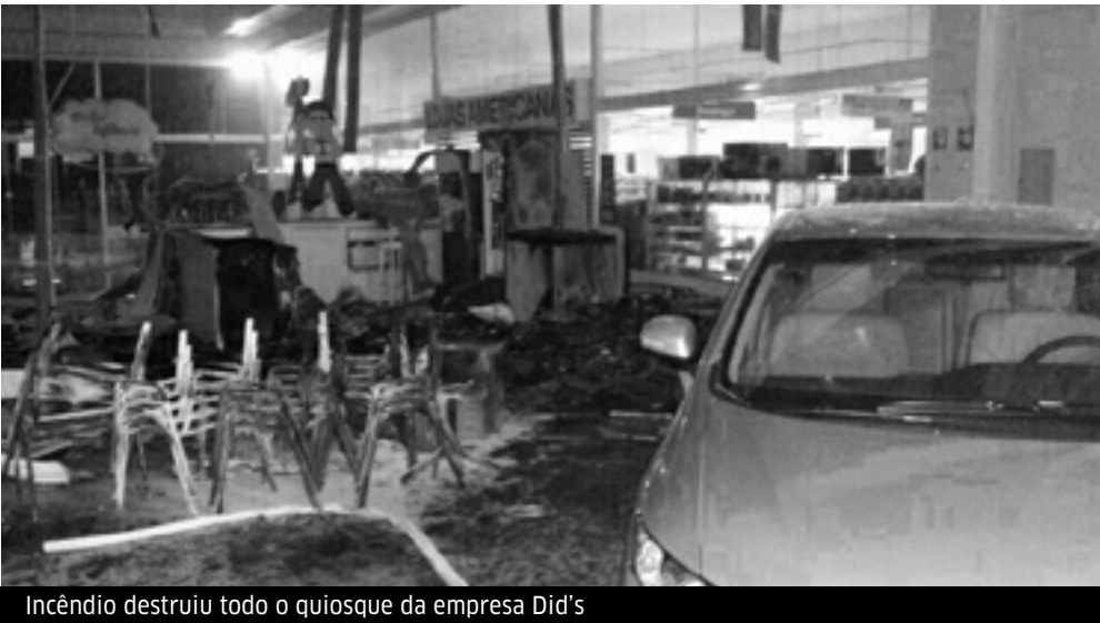
Incêndio destruiu todo o quiosque da empresa Did's
