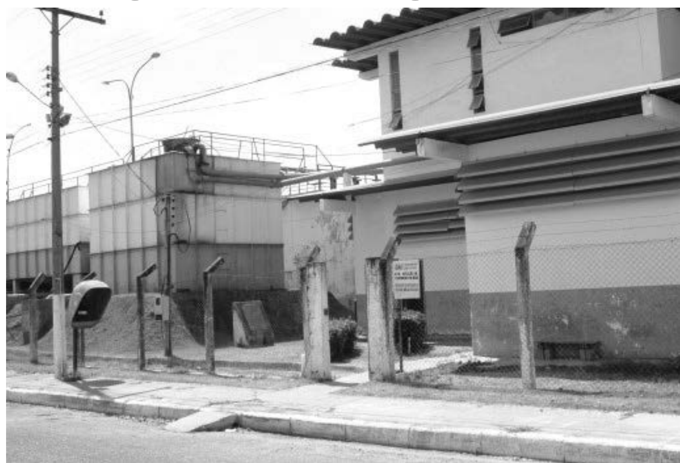
Estação de tratamento de Água da cidade de Barra do Bugres
