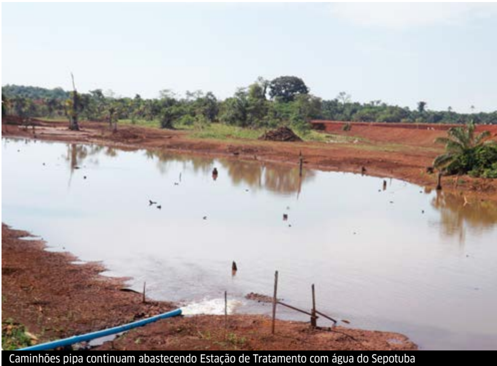
Caminhões pipa continuam abastecendo Estação de Tratamento com água do Sepotuba
