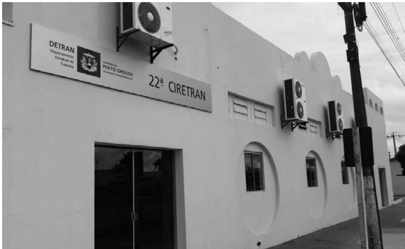
O novo prédio está localizado na Avenida Brasil, esquina com a Rua José Garcia Lacerda (32)
