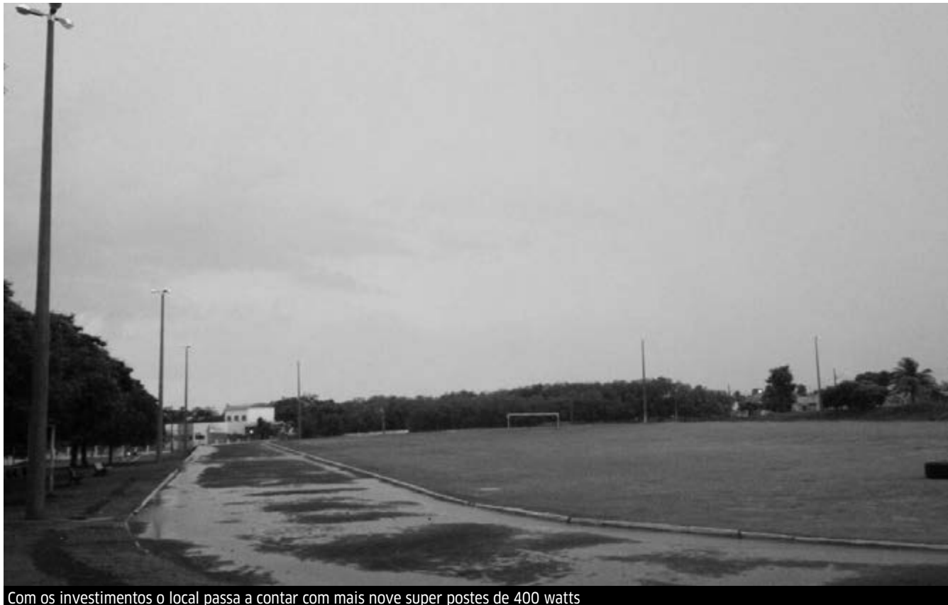
Com os investimentos o local passa a contar com mais nove super postes de 400 watts
