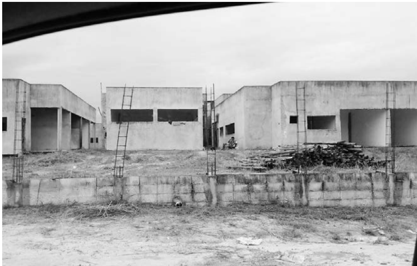
A obra está orçada em seis milhões e 900 mil e hoje a nova empresa que dará seguimento no projeto será conhecida
