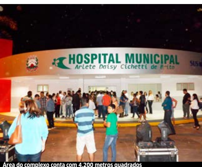
Área do complexo conta com 4.200 metros quadrados
