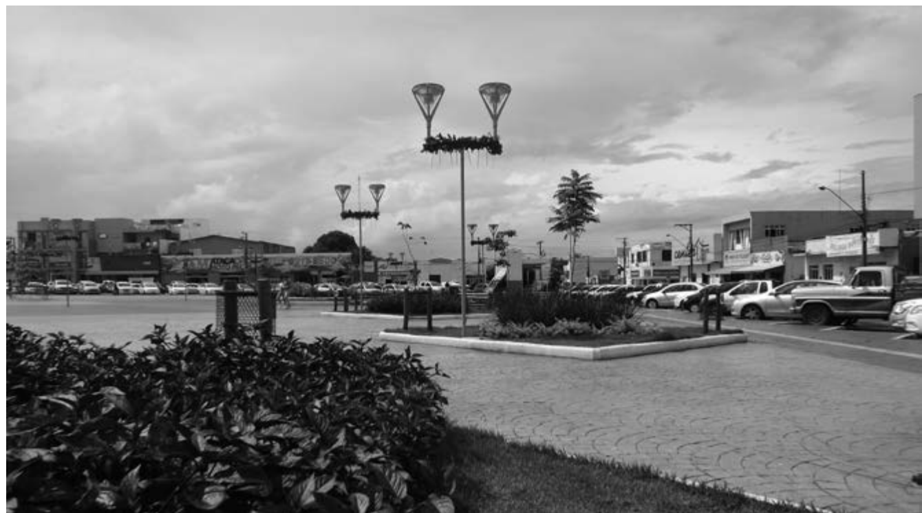
Configuração da praça foi modificada; obra foi entregue em 02 de Julho
