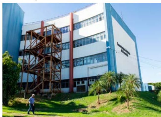
O adiamento visa o aprofundamento das discussões
