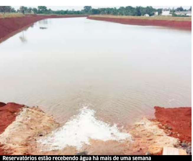
Reservatórios estão recebendo água há mais de uma semana
