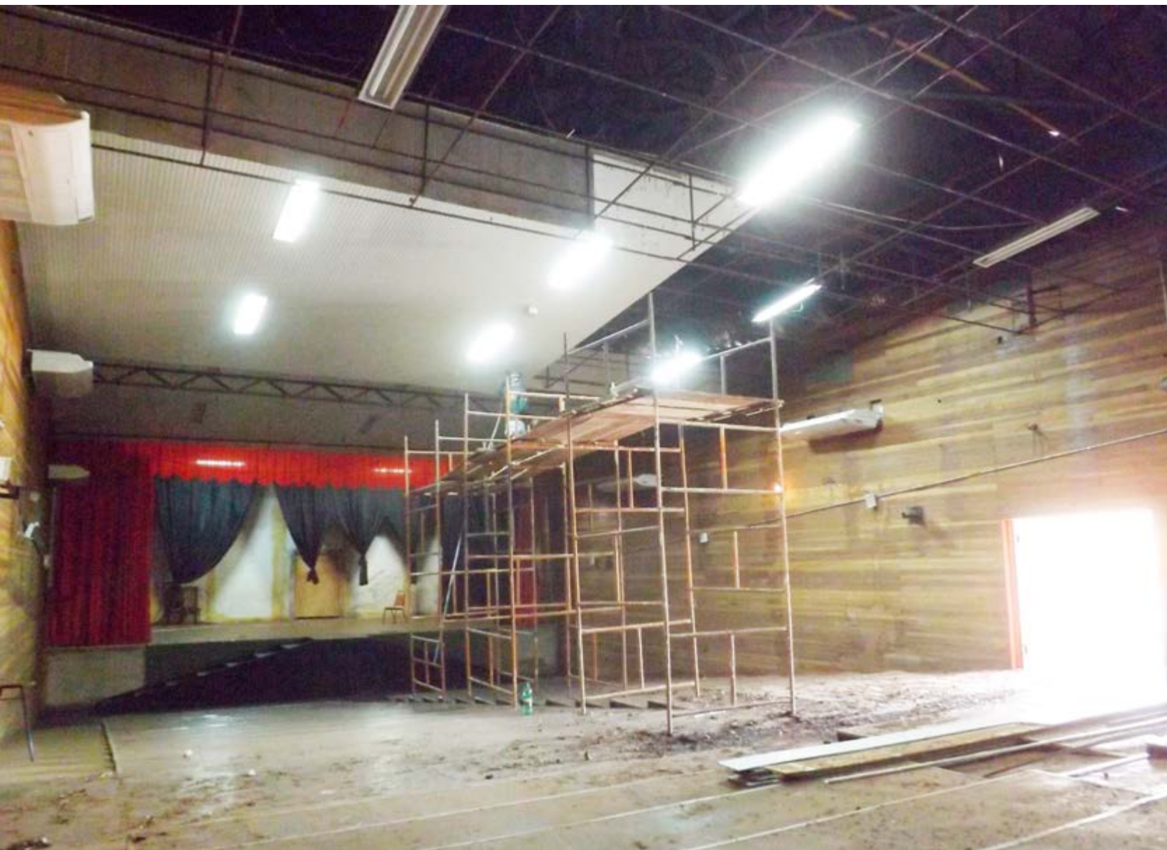
Os procedimentos para reforma como a remoção do teto e piso já iniciaram
