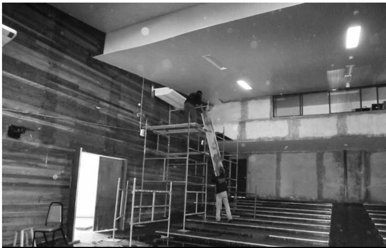
Os procedimentos para reforma como a remoção do teto e piso já iniciaram
