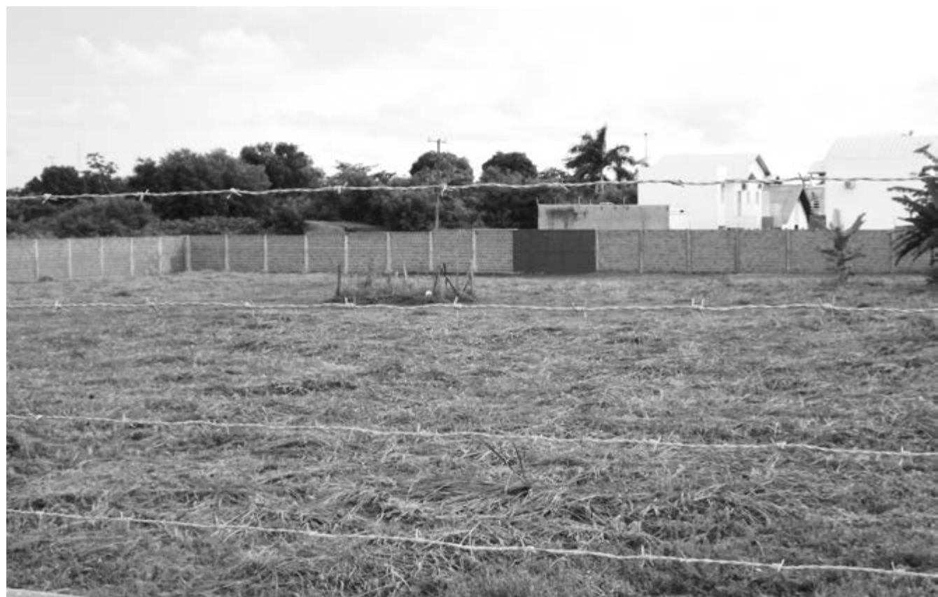
O local, que será utilizado para depósito de veículos, já está recebendo melhorias
