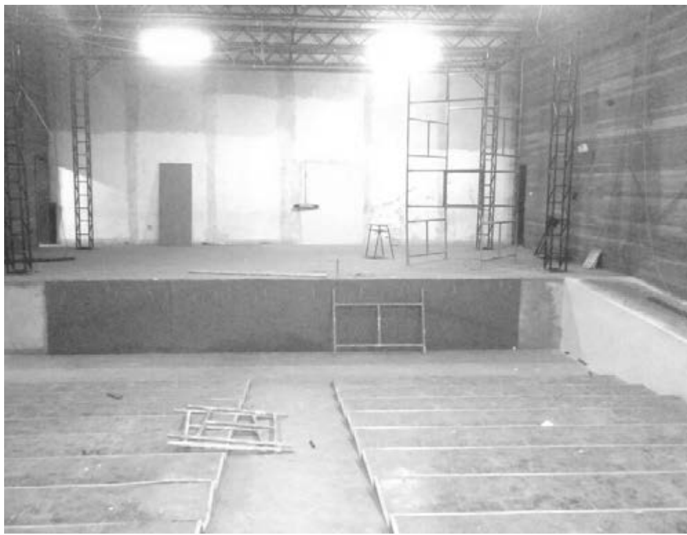
Com investimento total de R$ 109.227,57, a Trubian Engenharia é responsável pela reforma
