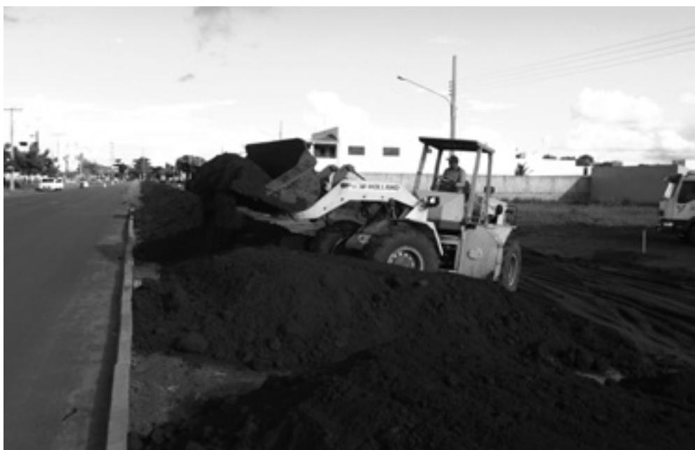
Mais de R$ 17 milhões são para pagamentos mensais e investimentos, como em obras de pavimentação asfáltica
