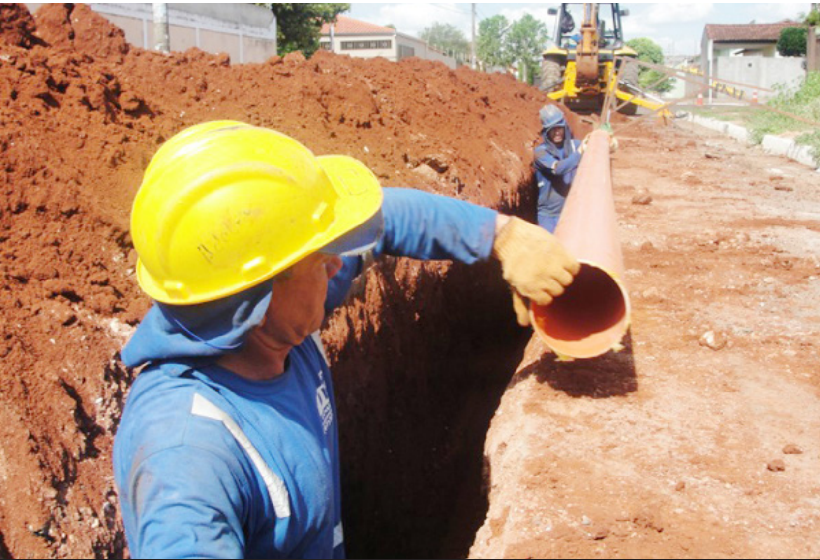
Obras estão em andamento no município para aumentar estatística
