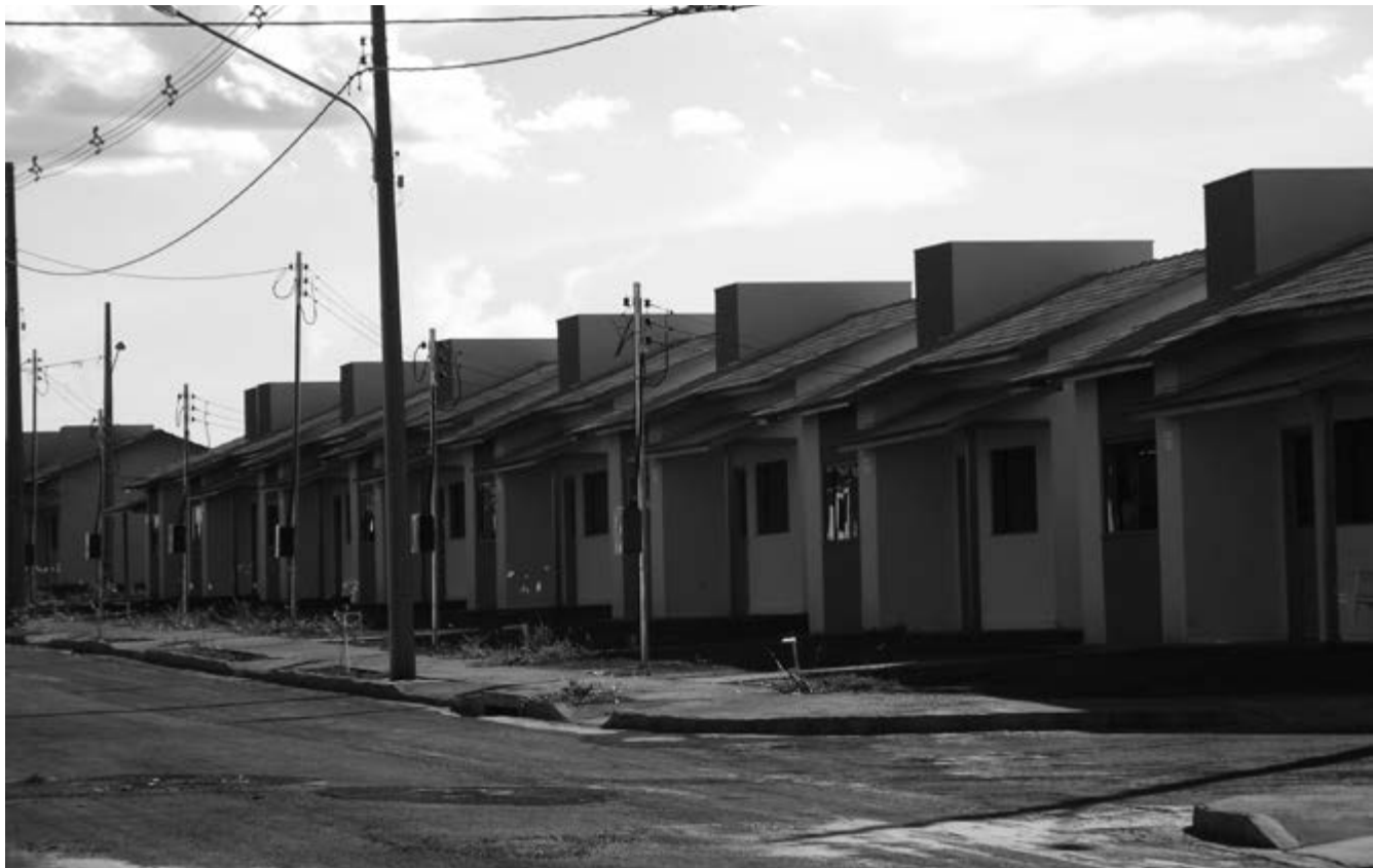
Casas já estão prontas, faltando apenas a interligação na rede de esgoto
