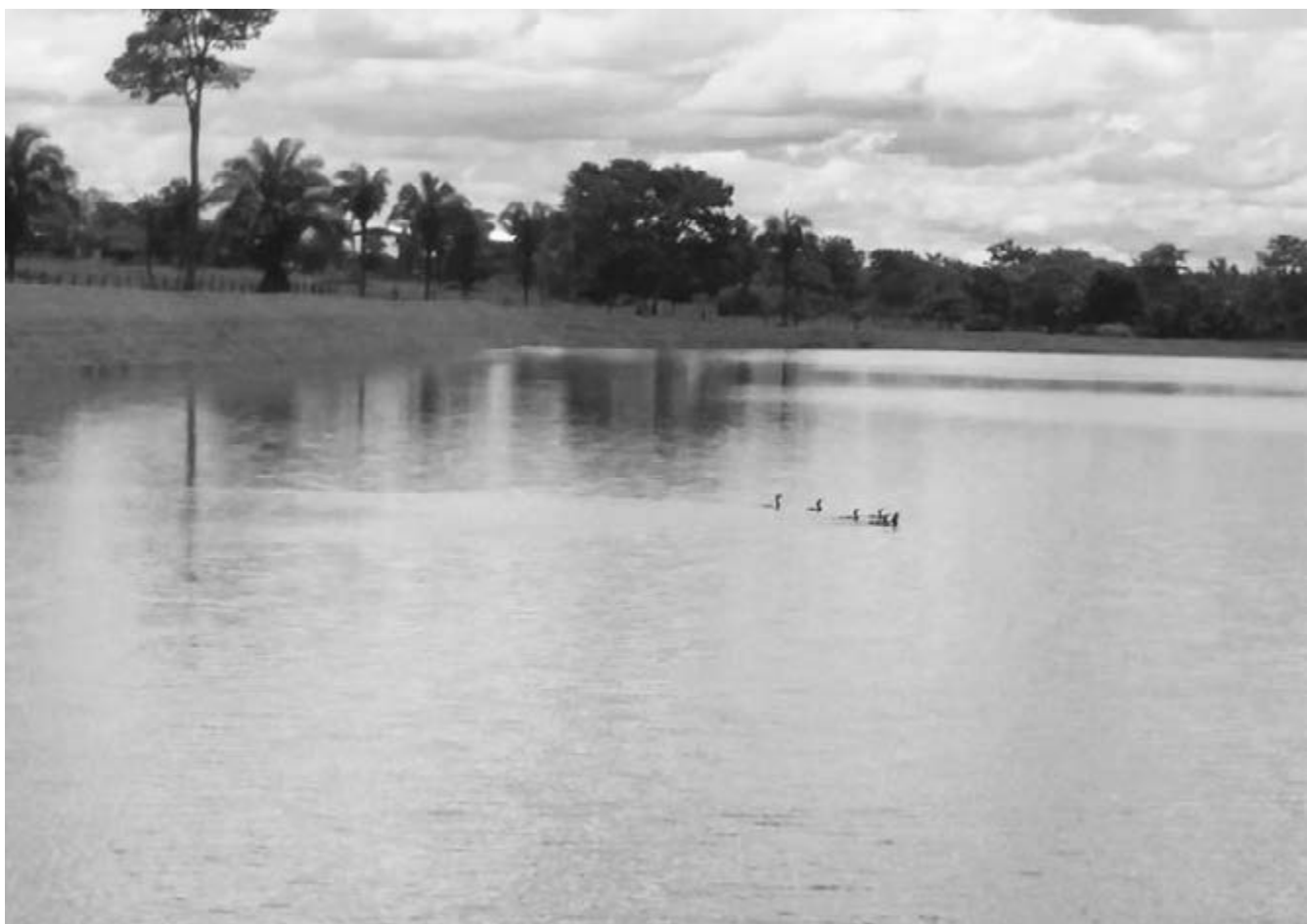
Reservatório está em fase de acabamento
