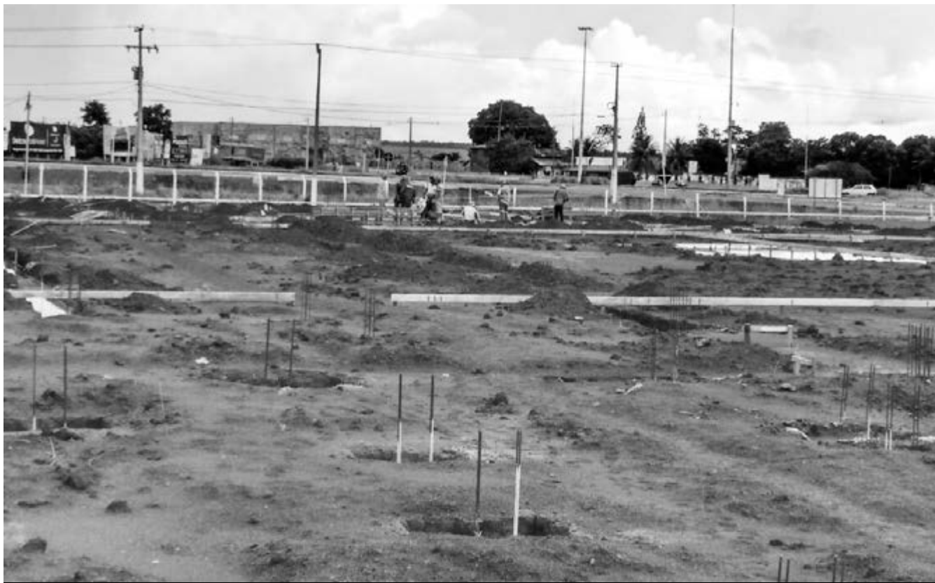
A empresa Geosolo Engenharia Planejamento e Consultoria LTDA, é a responsável pela obra
