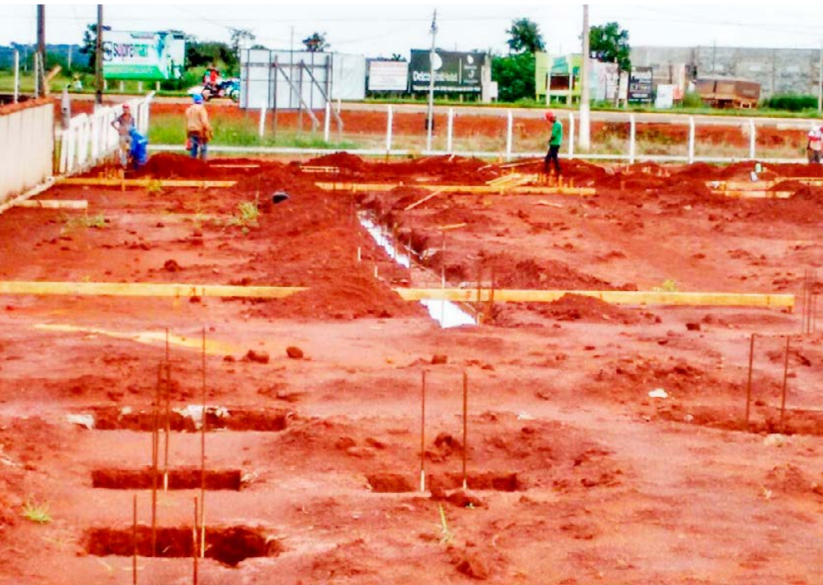
A empresa Geosolo Engenharia Planejamento e Consultoria LTDA, é a responsável pela obra
