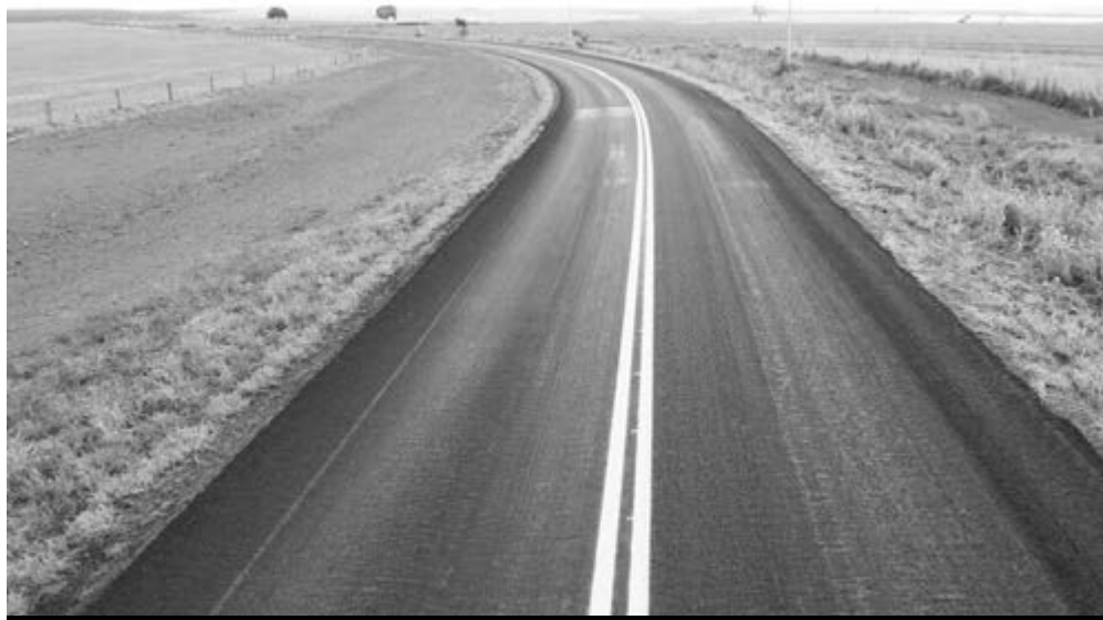
Conclusão de obra está prevista para segundo semestre deste ano
