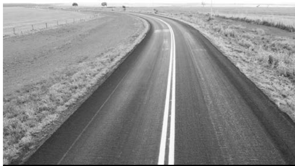
Conclusão de obra está prevista para segundo semestre deste ano
