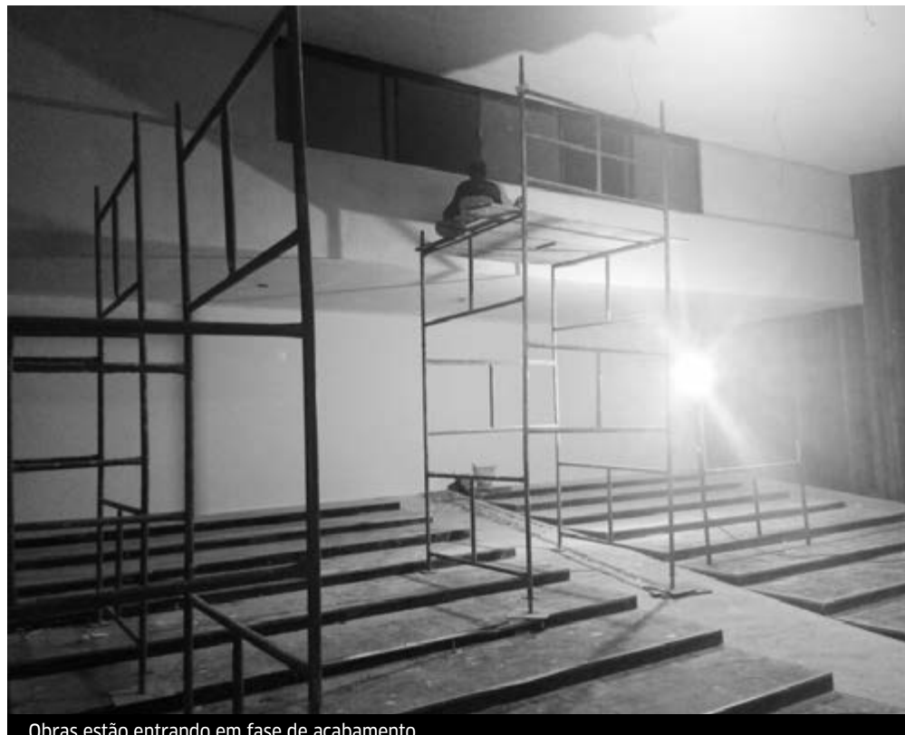
Obras estão entrando em fase de acabamento
