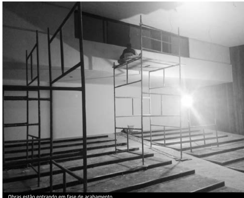
Obras estão entrando em fase de acabamento
