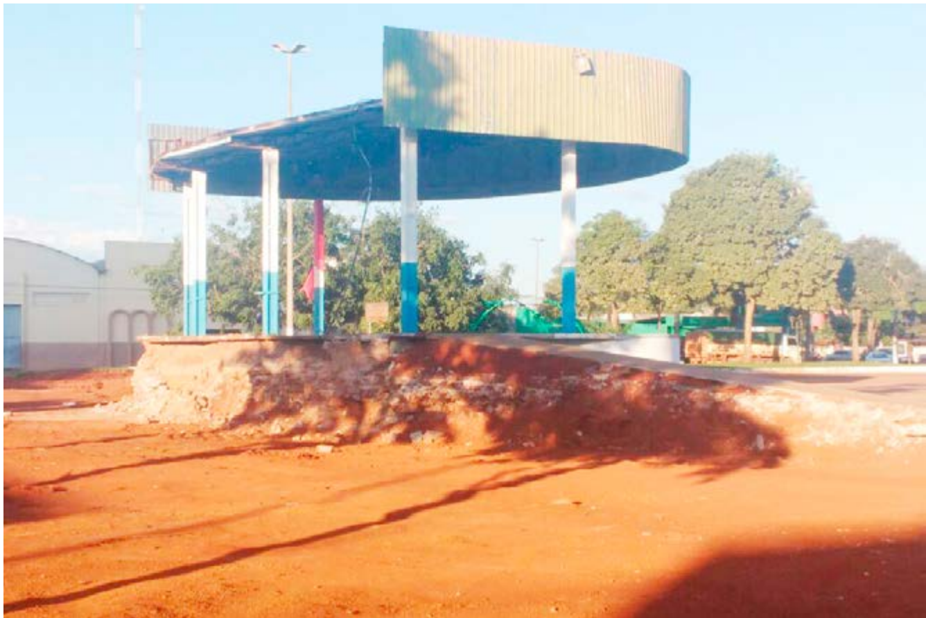
Processo de limpeza do local foi iniciado recentemente
