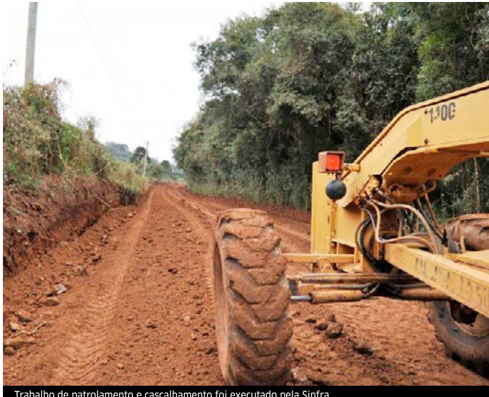
Trabalho de patrolamento e cascalhamento foi executado pela Sinfra
