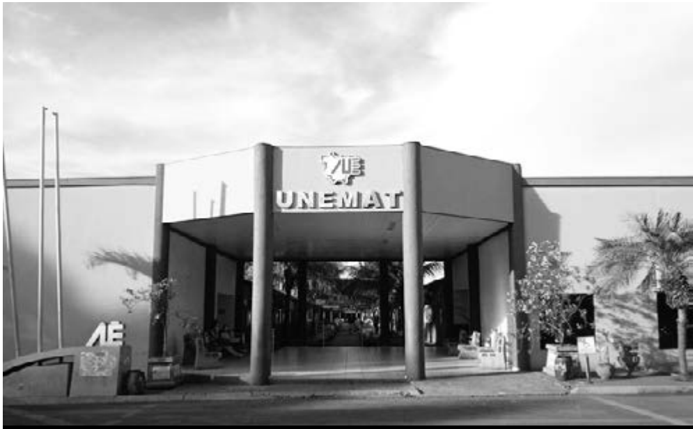
Estão sendo construídas mais 20 salas .Cerca de 2 milhões foram investidos
