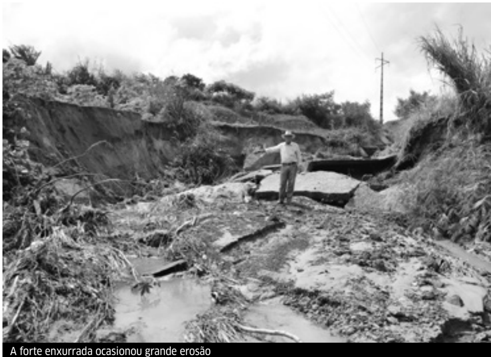
A forte enxurrada ocasionou grande erosão
