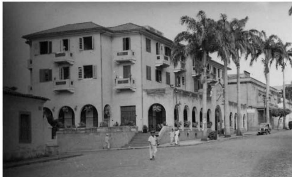
O Grande Hotel começou a ser construído em 1940
