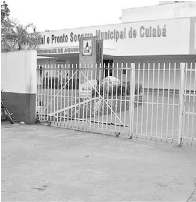
Criança está internada e teve parte do esôfago e do estômago corroídos
