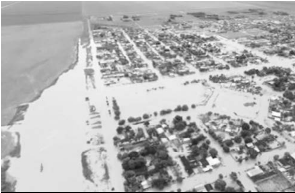
A obra visa evitar novos alagamentos no Jardim das Palmeiras
