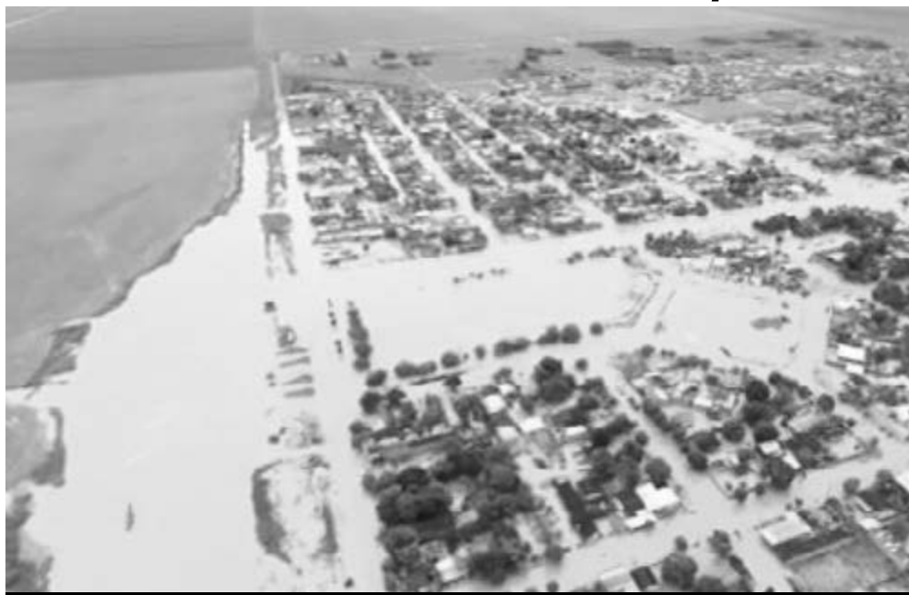
A obra visa evitar novos alagamentos no Jardim das Palmeiras
