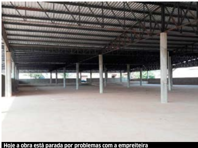
Hoje a obra está parada por problemas com a empreiteira
