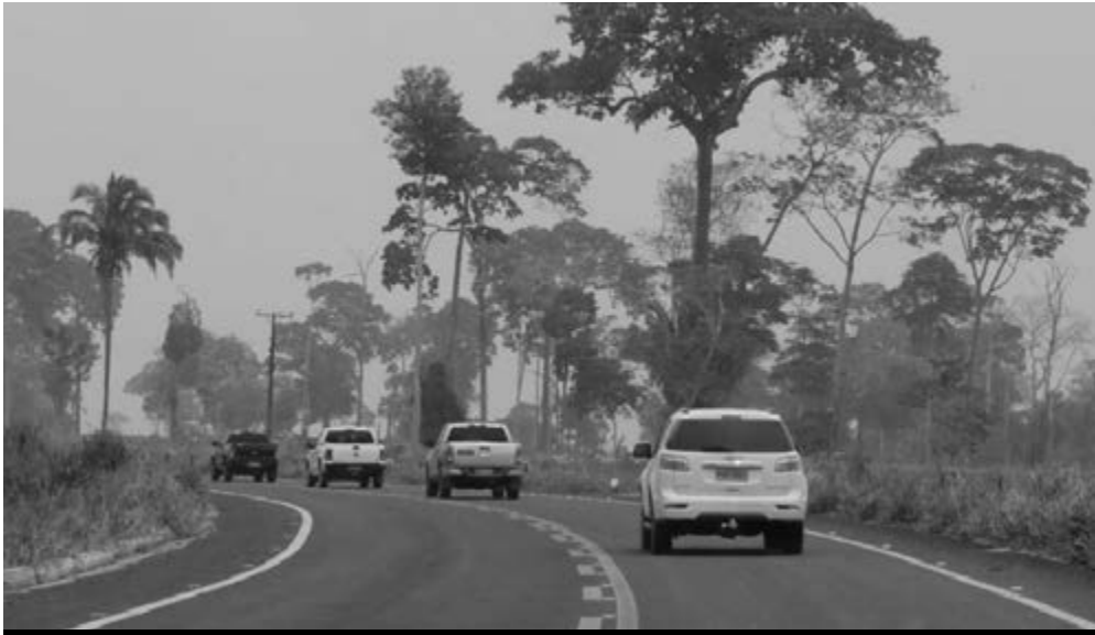
A entrega oficial de interligação asfáltica foi feita nesta terça-feira, 19, pelo governador Pedro Taques
