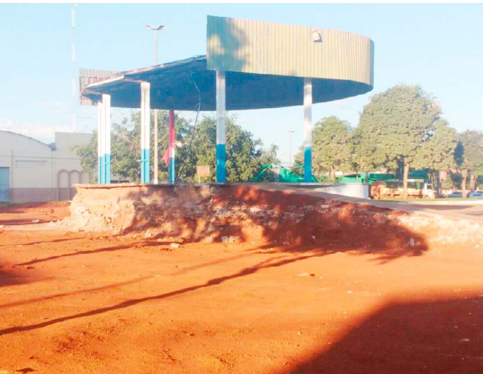
Obras estão paralisadas por falta de recursos
