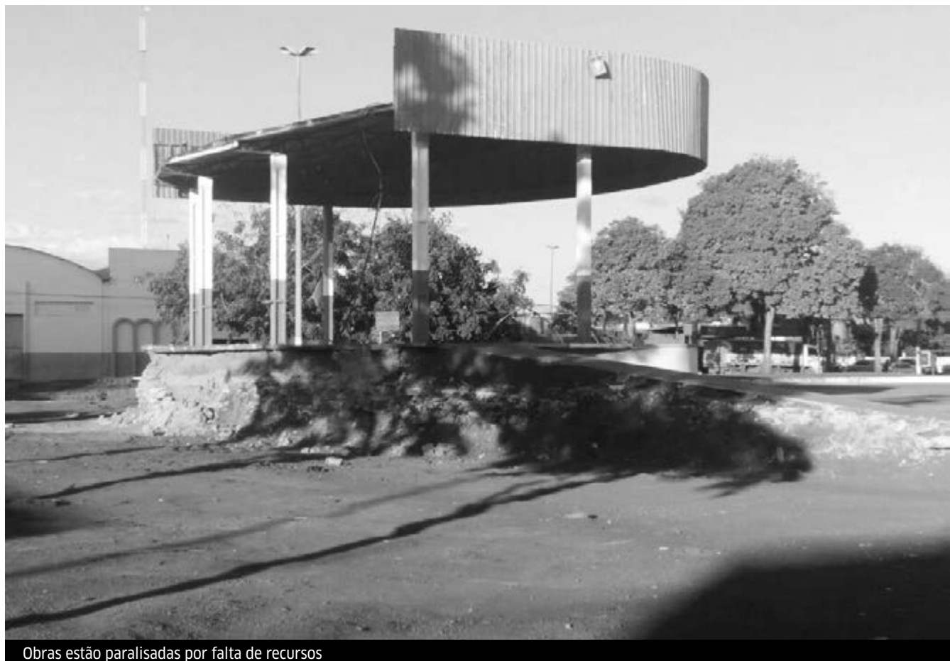
Obras estão paralisadas por falta de recursos
