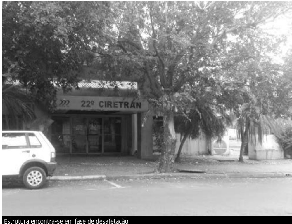
Estrutura encontra-se em fase de desafetação
