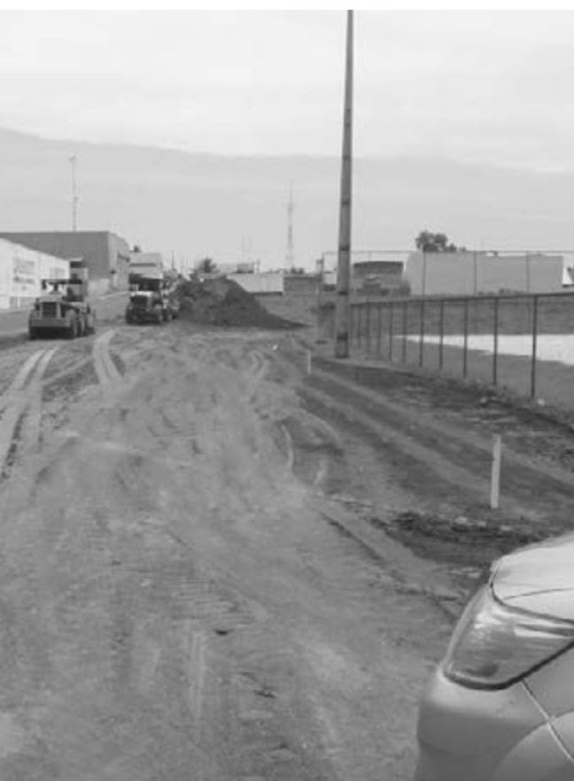
Pavimentação asfáltica está sendo realizada no Módulo Esportivo
