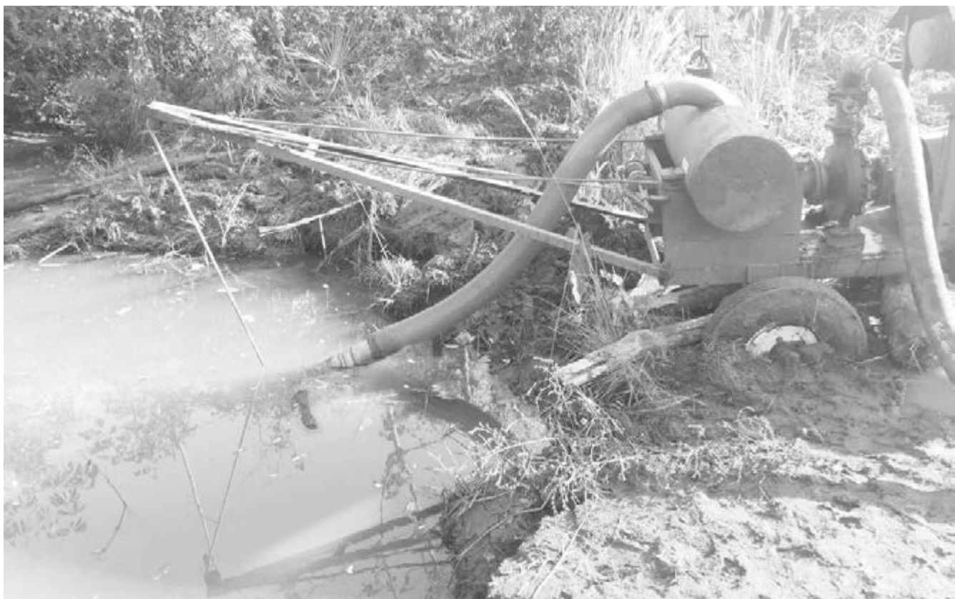
Ano passado, águas do rio Russo auxiliaram no combate a estiagem através de um sistema de captação
